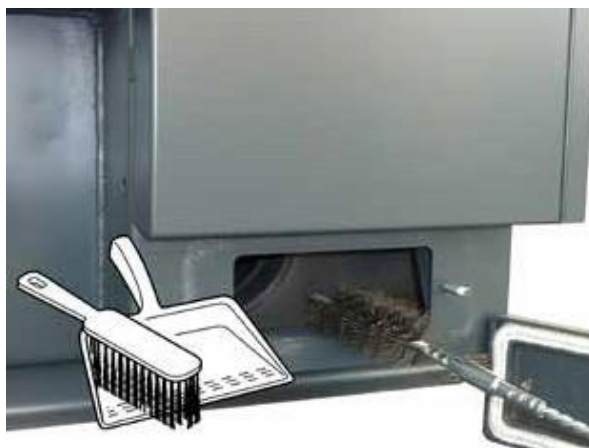
Čiščenje dimnega izmenjevalca
