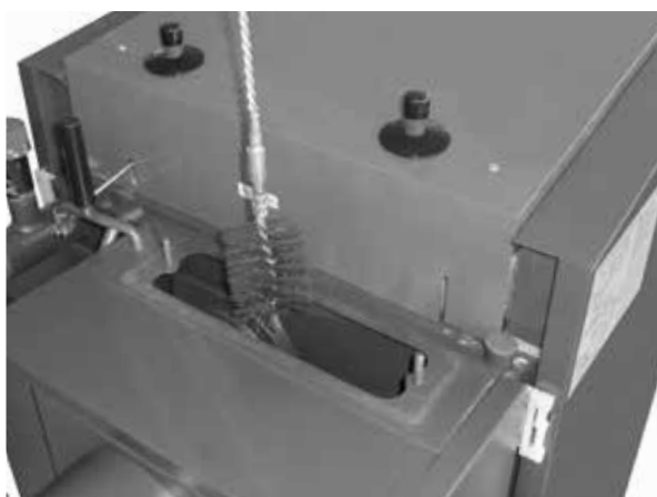
Čiščenje dimnega izmenjevalca in tubulatorjev
